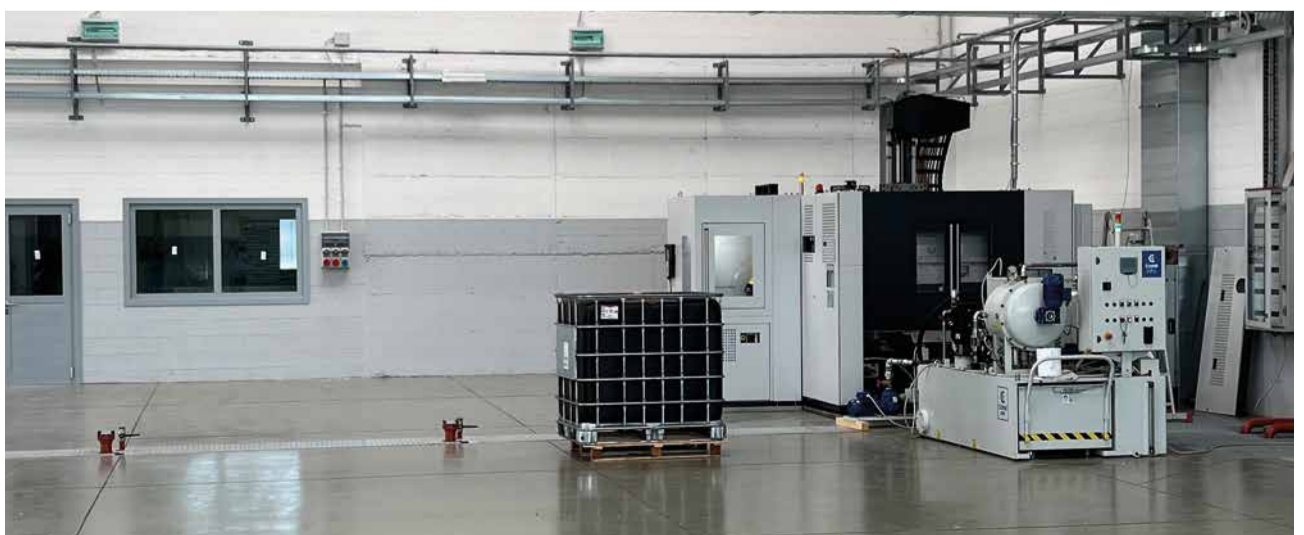
Livraison et installation de la nouvelle machine de rectification
